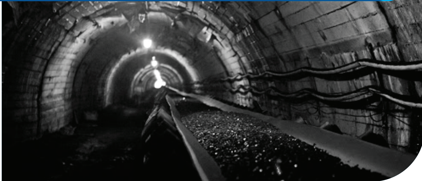
Băng tải Cao Su 75 sử dụng trong hầm lò Công ty Than Hà Lâm - TKV
