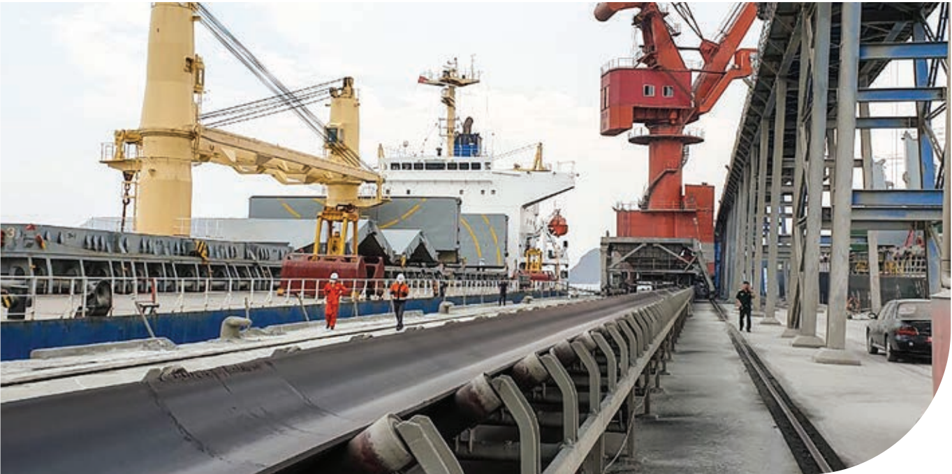
Băng tải Cao Su 75 lắp đặt cho tập đoàn The Vissai Tại cảng Nghi Thiết-Nghệ An
